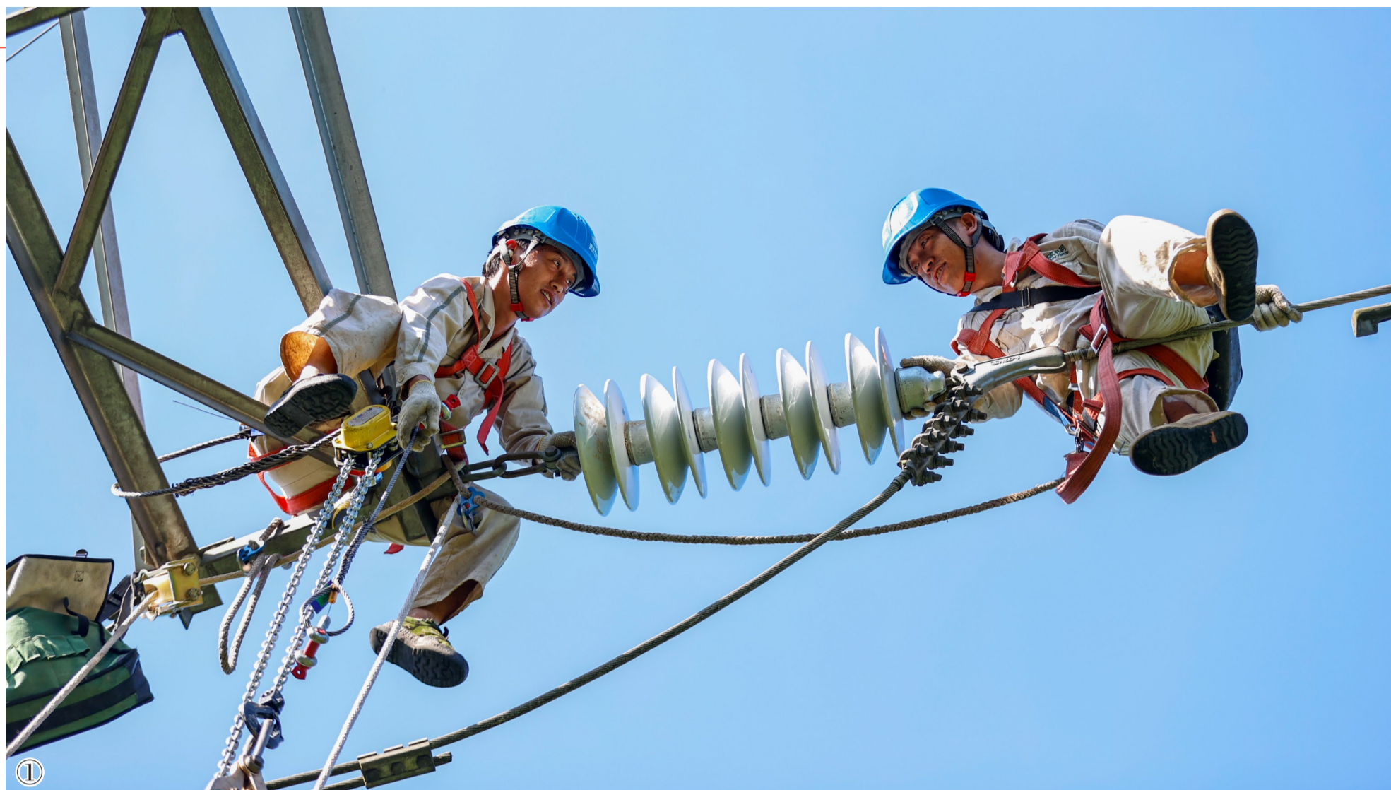
图①:7月22日,位于巴南区接龙镇的35千伏彭龙61号和62号杆,输电检修作业人员正在更换绝缘子。 图②:7月24日,重庆东站项目施工现场,600余名工人高温下施工。 图③:7月23日,重庆高新区自来水公司,工作人员在烈日下开展设备巡查工作。 图④:7月22日,北碚区北温泉街道,马中顶森林防火检查站工作人员正在清理道路障碍。 图⑤:7月23日,重庆北客车站,工人在进行列车整备作业。
