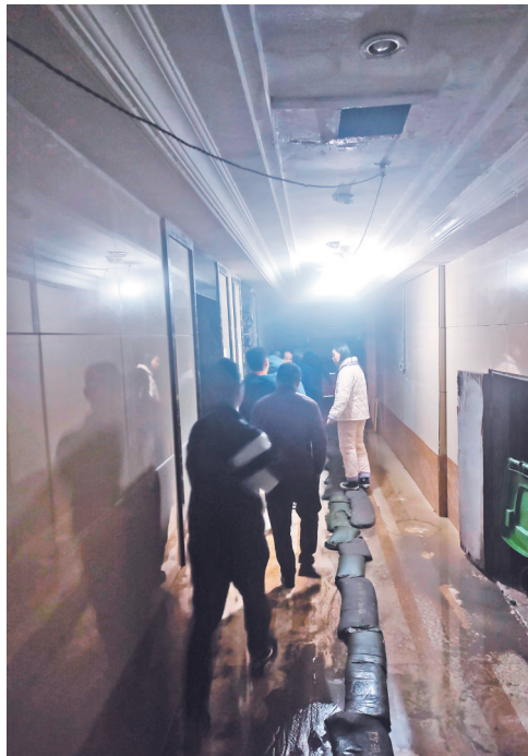
大渡口区八桥镇融城社区工作人员深夜协调解决楼栋排水管破裂问题。（受访者供图）
