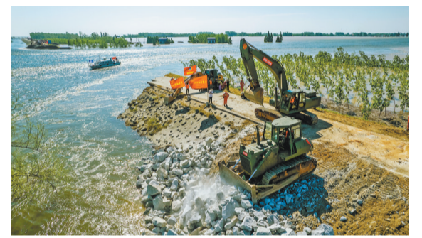
7月6日，华容县团洲垸，抢险人员尝试封堵决口(无人机照片)。
