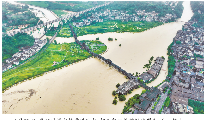
6月28日，黔江区濯水镇遭遇洪水，相关部门提前转移群众，无一伤亡。
