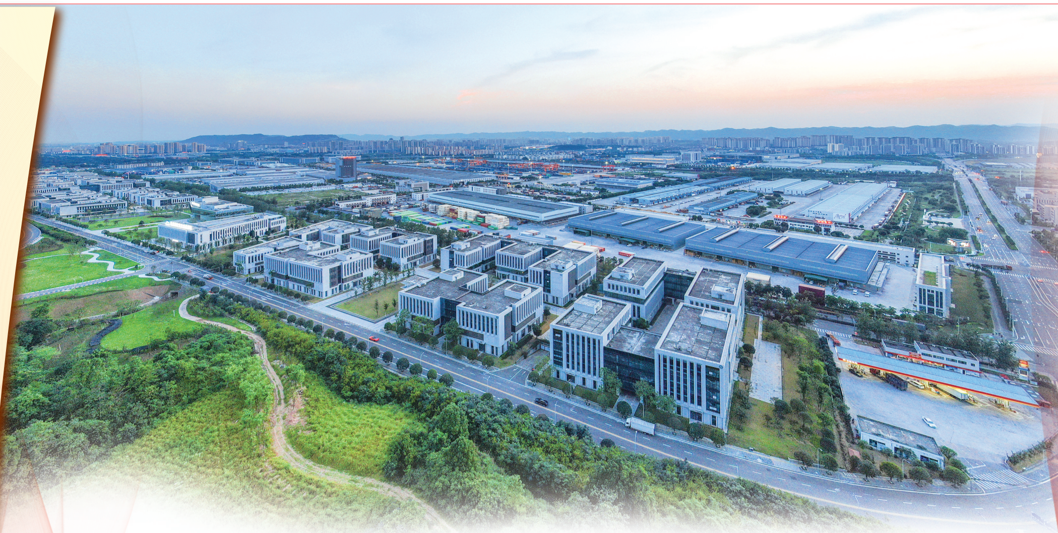
位于沙坪坝区的重庆国际物流枢纽园区 摄/郭晋
