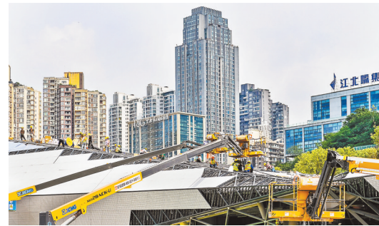
▲6月18日,建设中的江北嘴金融中心。记者 齐岚森 摄/视觉重庆
