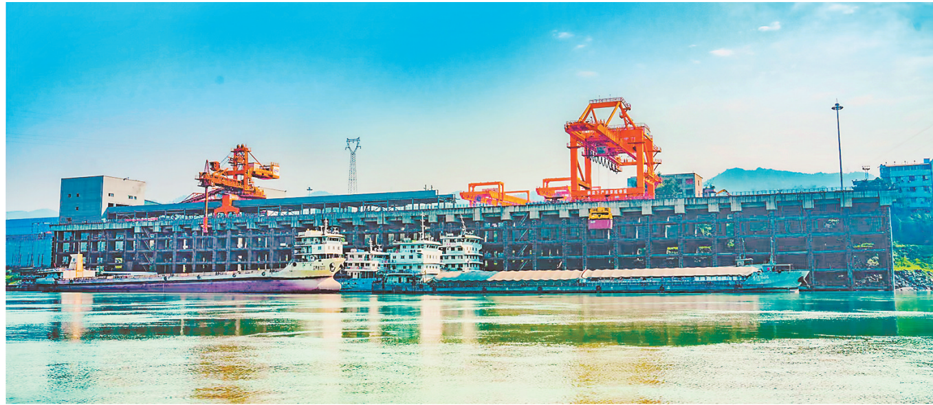
全市五大区域性重点港口之一的珞璜港。(受访者供图)
