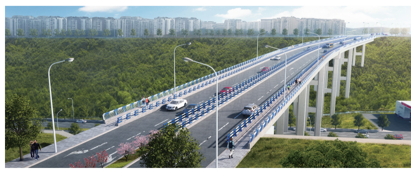
空港园区至航空城连接道工程桥面鸟瞰图
