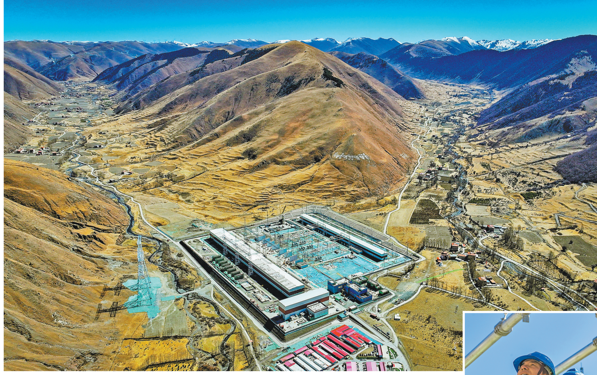
三月二十九日，四川省甘孜藏族自治州康定市呷巴乡甘孜1000千伏特高压变电站项目，该站海拔三千四百五十米，是在建的全国海拔最高的特高压变电站。本版图片除署名外均由首席记者 龙帆 摄 视觉重庆
