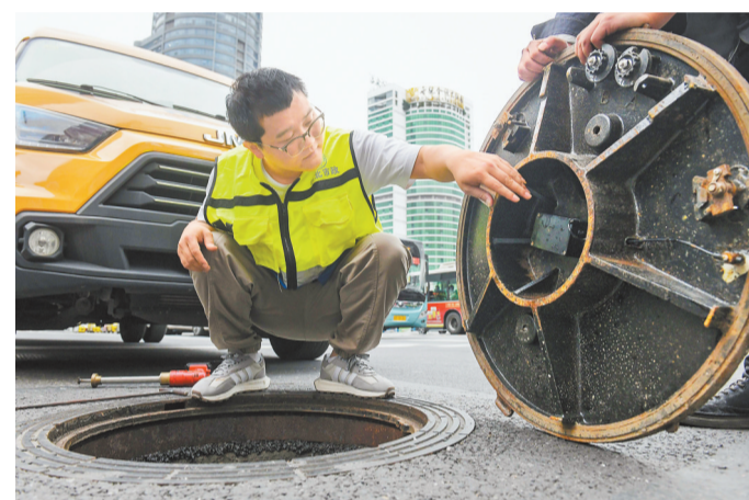
江北区北城天街，工作人员打开智能井盖，查看其背部的智能密码锁、机械密码锁和传感器等装置。(摄于2023年10月9日) 记者 张锦辉 摄/视觉重庆
