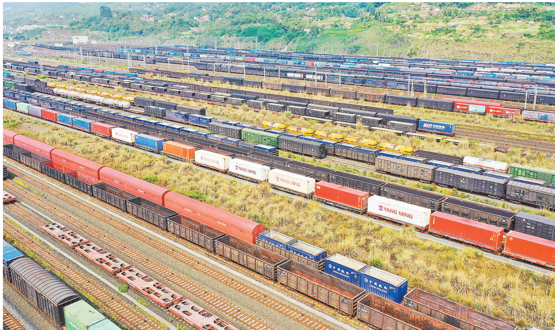
4月13日，位于沙坪坝区国际物流枢纽园区的兴隆场编组站。该站是西南地区规模最大的铁路编组站，为中欧班列、西部陆海新通道班列等国内外班列高效运行提供运力保障。 通讯员 郭晋 摄/视觉重庆
