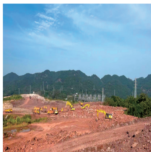
建设中的重庆枢纽港产业园
