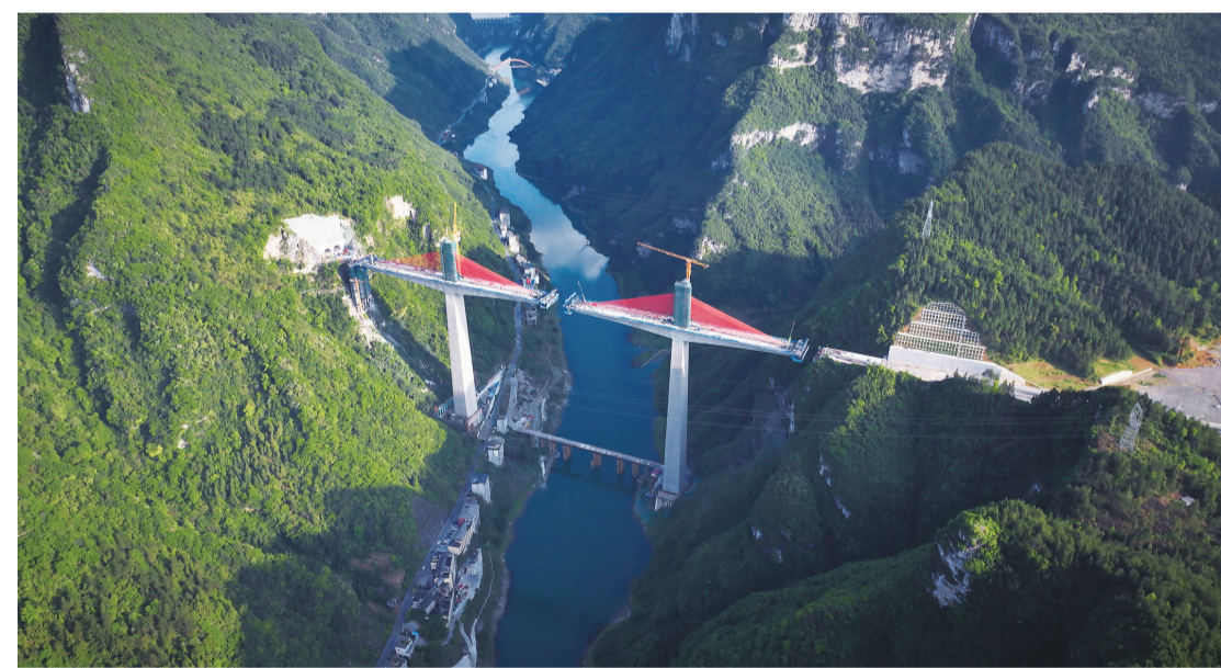
渝湘复线彭西路磨寨乌江特大桥正在进行上部结构施工
