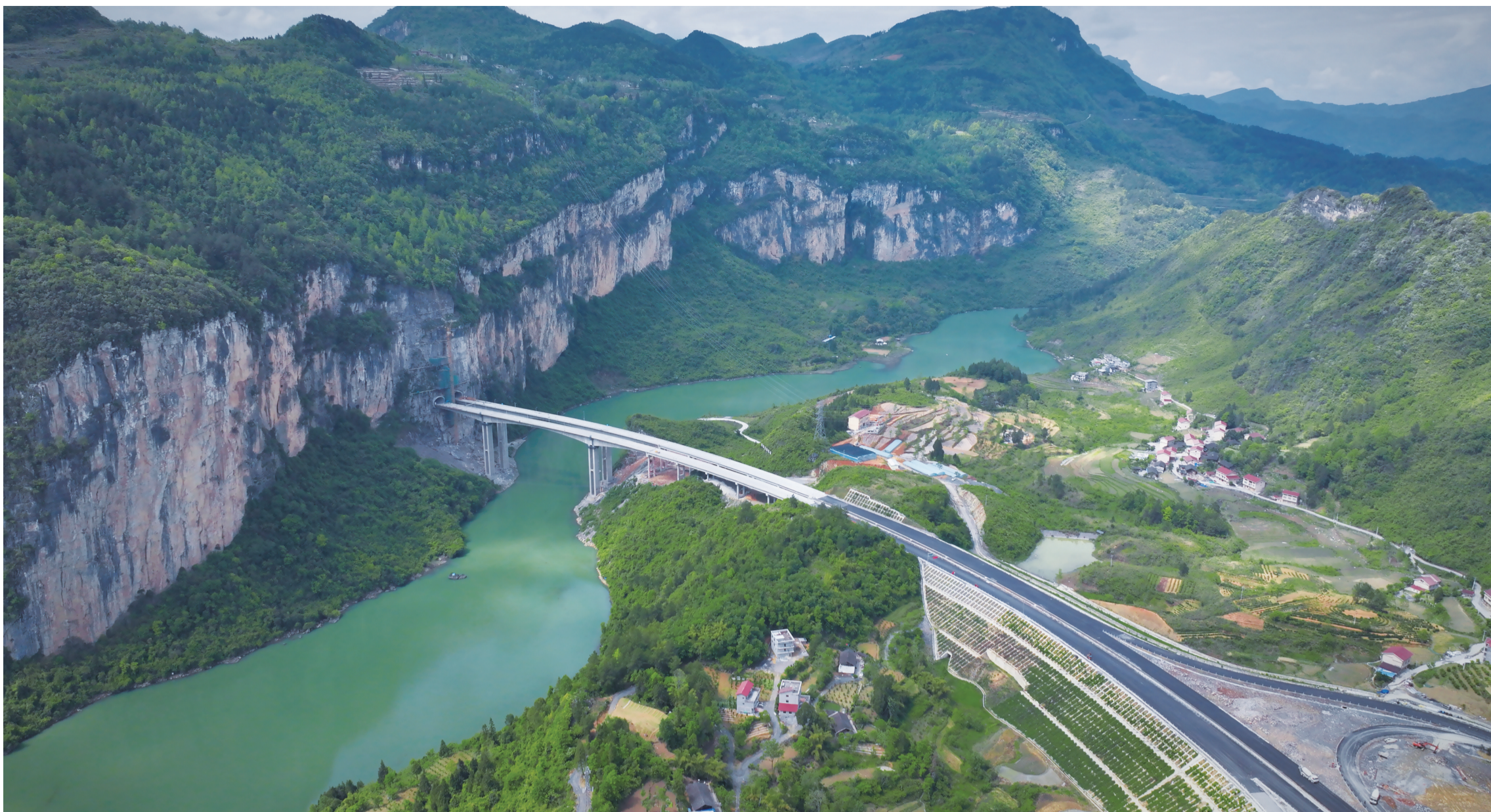
渝湘复线彭西路阿莲江特大桥已完成合龙
