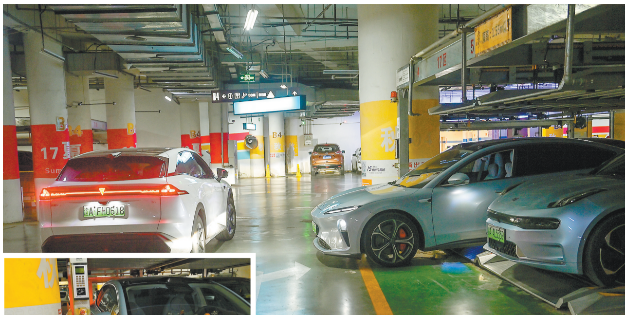
▲4月11日,渝中区国泰广场地下停车场,一辆新能源车(右二)正尝试停入机械停车位。 ▲4月11日,渝中区国泰广场地下停车场,一辆停入机械停车位的新能源车,车身两侧与机械轨道之间的间隙大约有1厘米。 记者 郑宇 摄/视觉重庆
