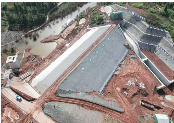
铜车坝水库工程主坝大坝封顶
