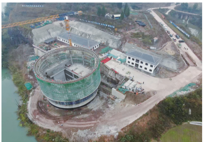
建设中的渝西水资源潼南项目区桂林泵站
