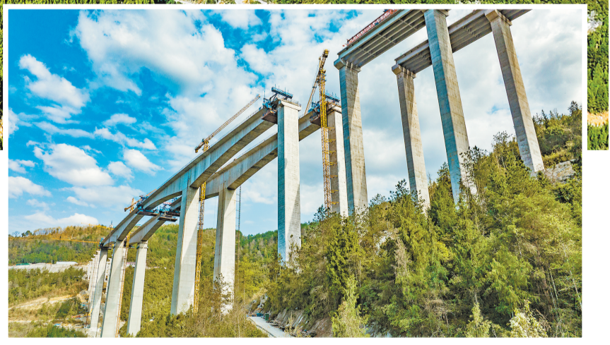
▲在建的渝湘复线高速公路黄草乌江特大桥。(中铁十五局供图)
