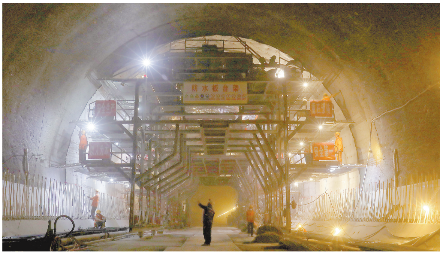
3月30日，渝湘高铁重庆至黔江段全线最长隧道——白马山隧道贯通。图为中铁十一局的技术工人正在贯通点进行施工。
