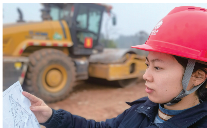
徐颖雪在铜梁1000千伏变电站查看施工图纸 摄/张桦
