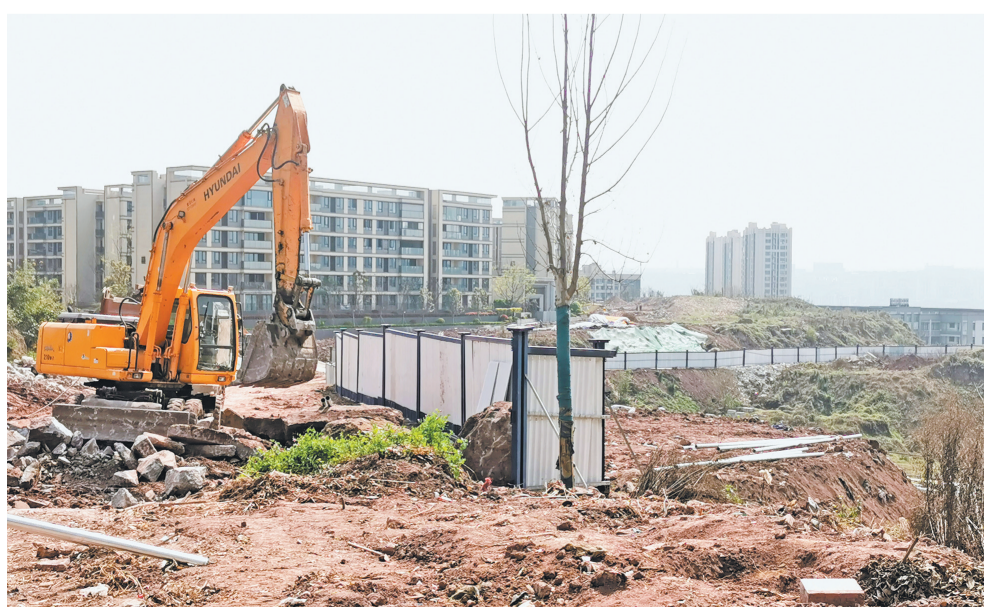
小区旁的空地正施工。
