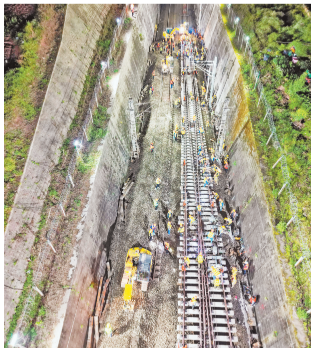
▲繁忙的施工现场。 通讯员 欧阳开源 摄/视觉重庆 ▲施工人员利用机械设备推送轨排。 通讯员 罗文武 摄/视觉重庆
