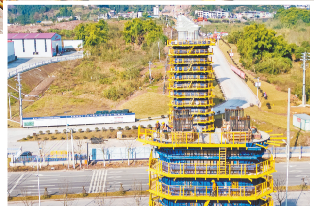
▲1月4日，西渝高铁开州段赵家普里河特大桥正在施工。西渝高铁是国家“八纵八横”高速铁路的重要组成部分，建成后将进一步强化成渝地区双城经济圈与关中平原城市群之间的联系。 记者 尹诗语 摄/视觉重庆
