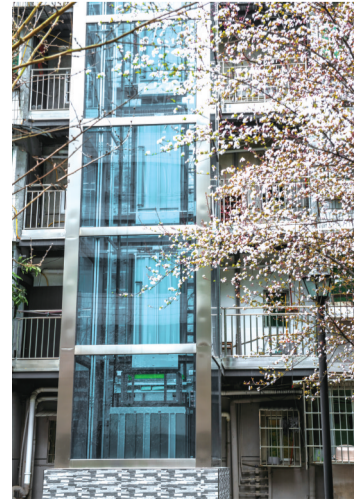
电力公司家属院小区加装的电梯
