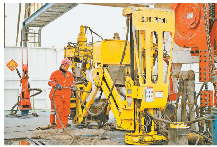
石油工人在深地塔科一井协同机械进行钻井作业。 新华社记者 李响 摄
