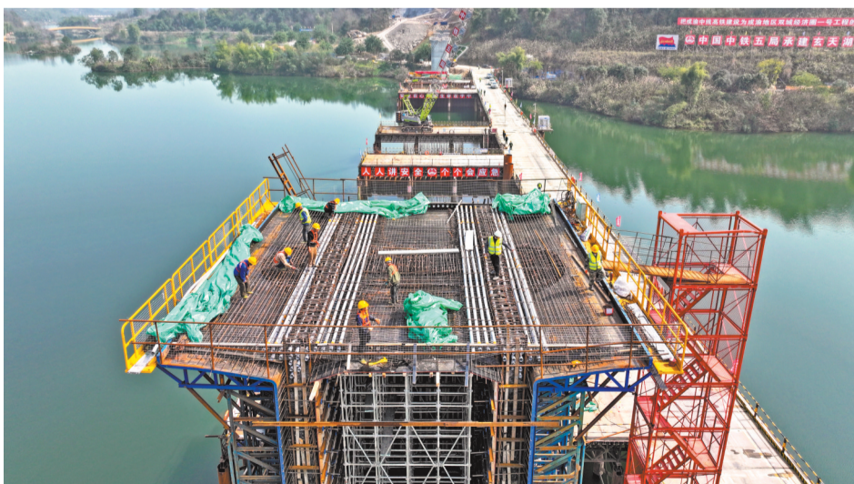
成渝中线高铁玄天湖大桥施工现场。
