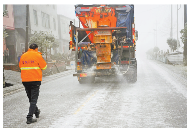
▲2月22日,酉阳县省道305线毛坝至兴隆路段,县公路事务中心融雪化冰车满载20余吨融雪化冰剂进行喷洒作业,确保交通顺畅。
