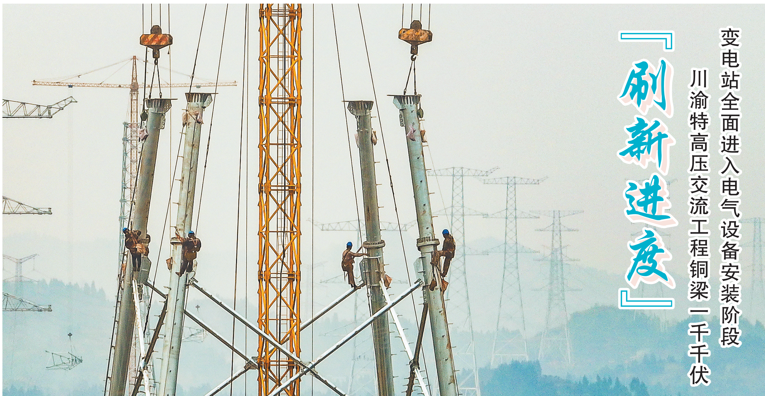
▲1月9日,川渝特高压线路工程(重庆段)铁塔塔基建设现场,施工人员正在吊装铁塔地线支架。 首席记者 龙帆 摄/视觉重庆
