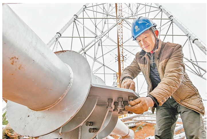
▲1月9日,川渝特高压线路工程(重庆段)铁塔塔基建设现场,施工人员在组装铁塔支架。 首席记者 龙帆 摄/视觉重庆
