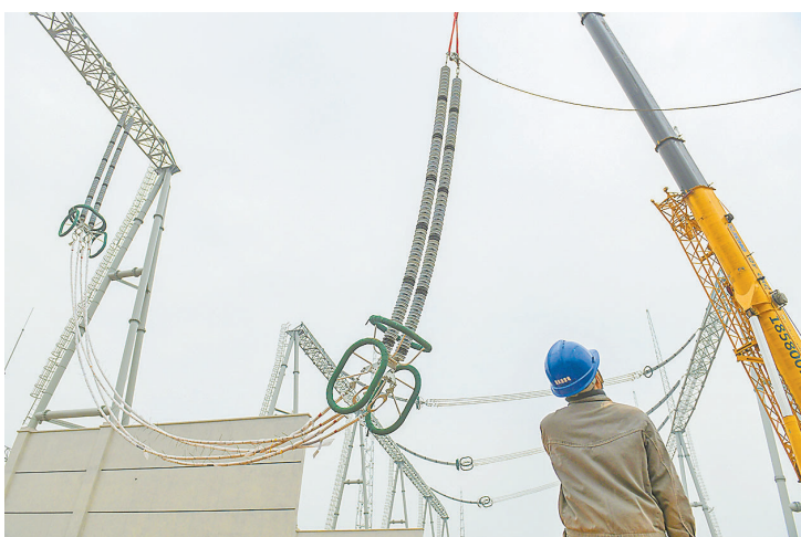
▲1月30日,川渝特高压交流工程铜梁1000千伏变电站施工现场,国网重庆市电力公司施工人员在吊装软母线。 记者 张锦辉 摄/视觉重庆
