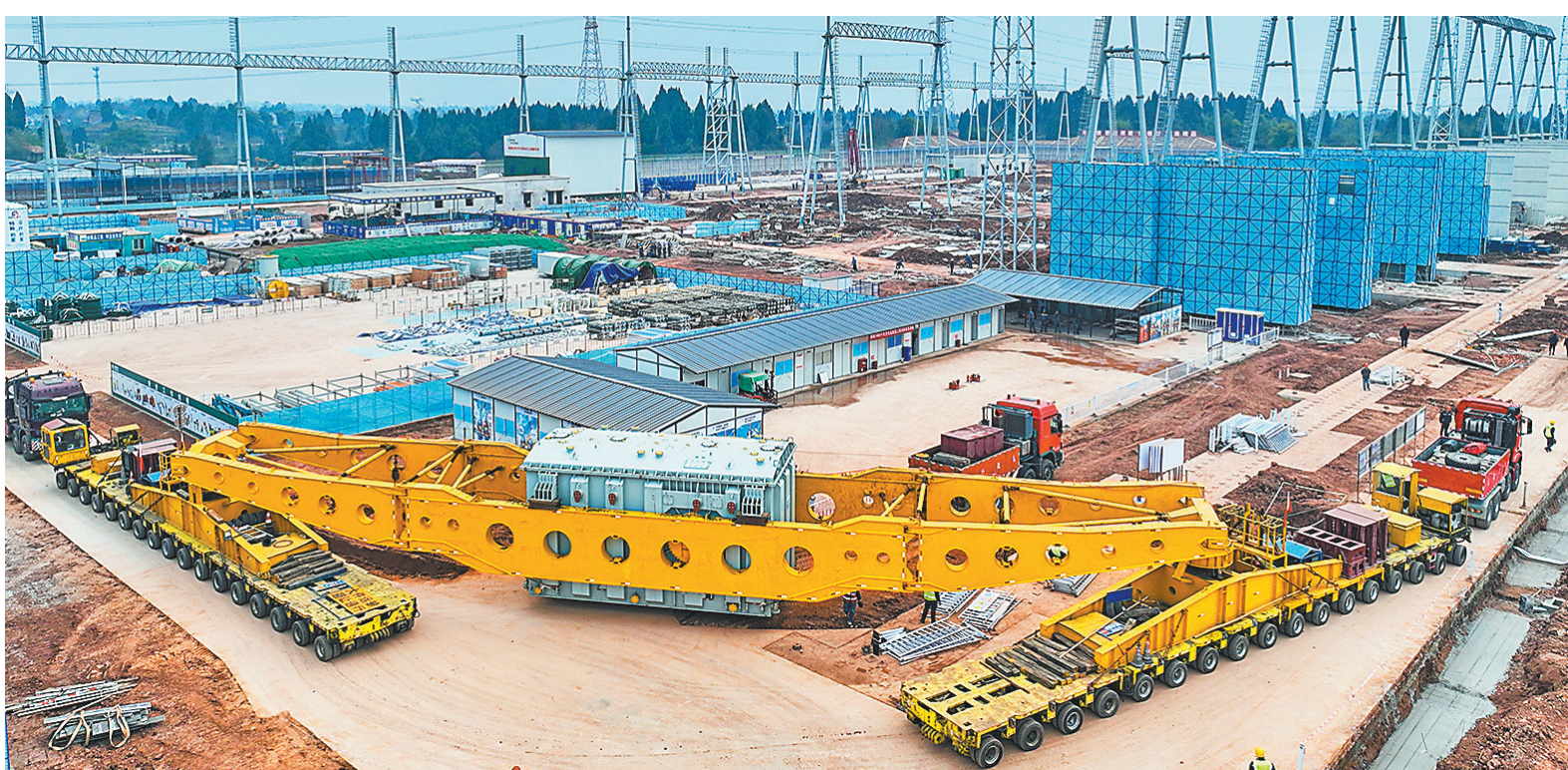
▲1月9日,川渝特高压交流工程铜梁1000千伏变电站施工现场,主变压器进站。 首席记者 龙帆 摄/视觉重庆
