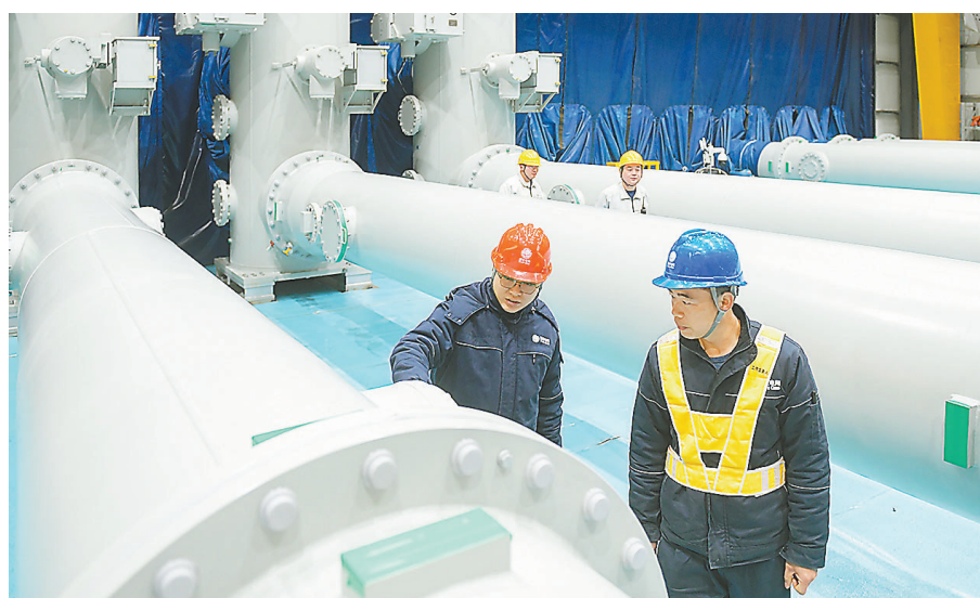
▲1月30日,川渝特高压交流工程铜梁1000千伏变电站,国网重庆市电力公司施工管理人员在1000千伏GIS移动无尘装配车间进行气室压力检查。 记者 张锦辉 摄/视觉重庆
