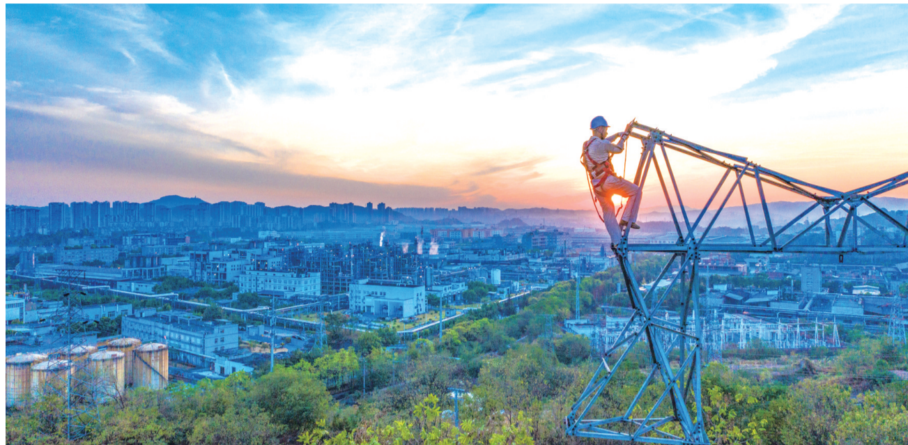
国网重庆电力员工登塔开展电力线路建设工作
