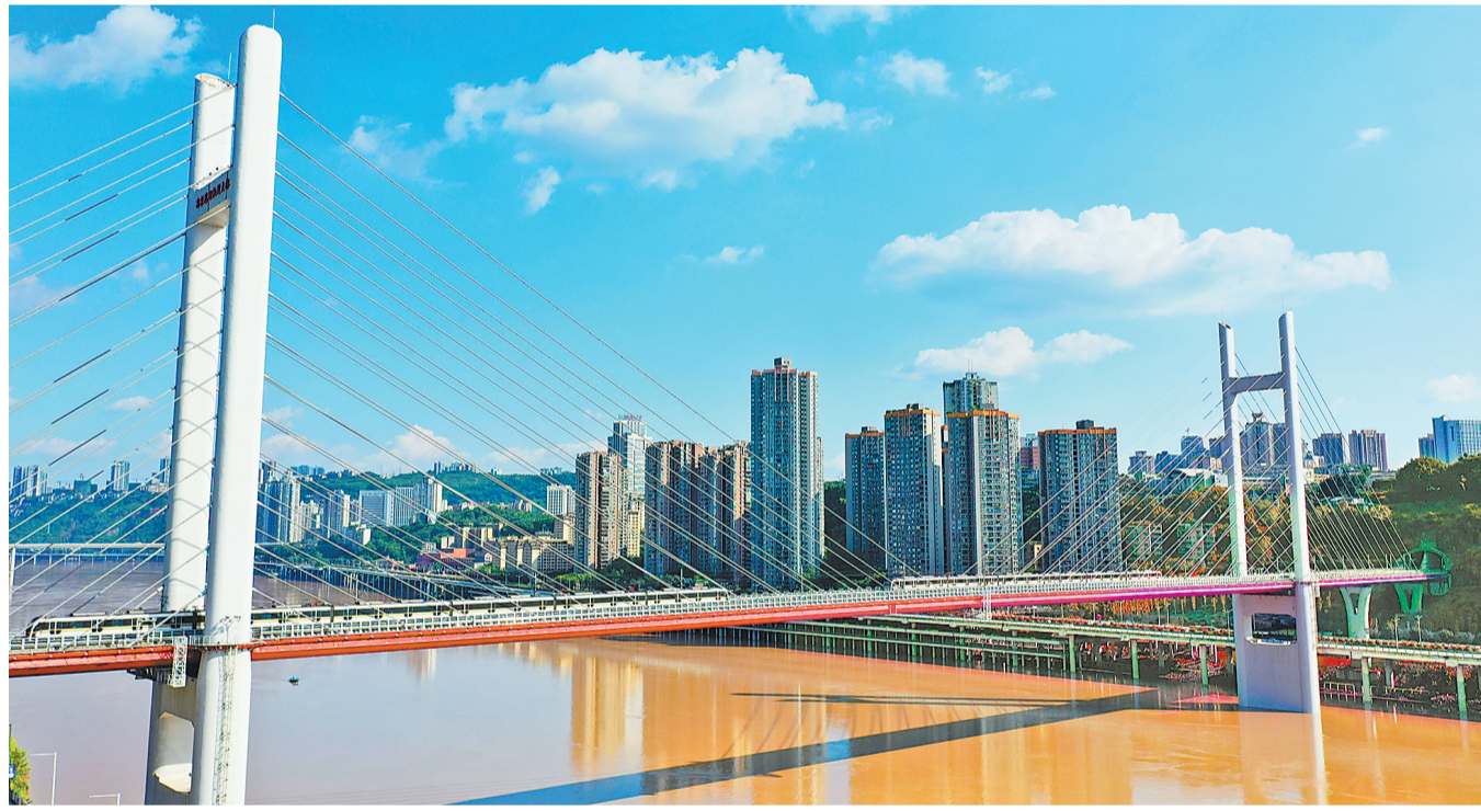
环线高家花园轨道大桥实景图。
