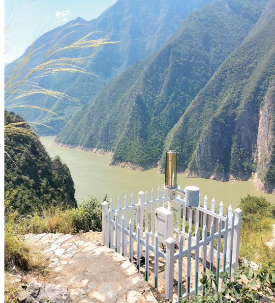
奉节干沟子危岩气象观测站
