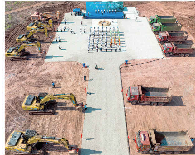
一批重大产业项目落户合川开工建设
