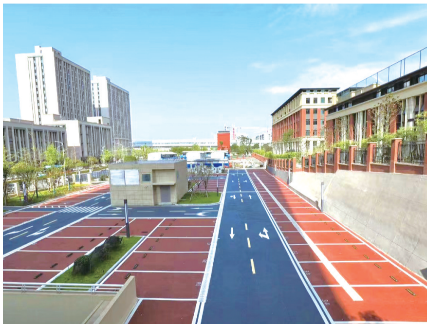
利用城区闲置地块建设小微停车场,解决市民停车问题 摄/胡瑾
