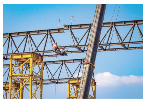
重庆东站项目施工现场
