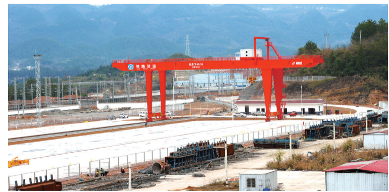
建设中的450万吨铁路物流货场
