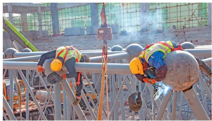
渝南职教城风雨操场顶棚正在进行钢构件焊接
