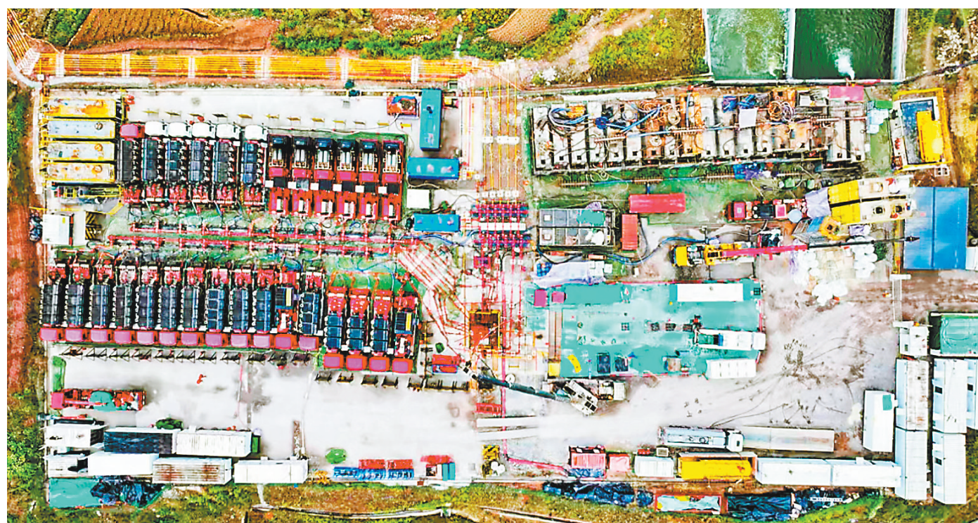
中国石化位于万州区的重点预探井——兴页9井压裂施工现场。
