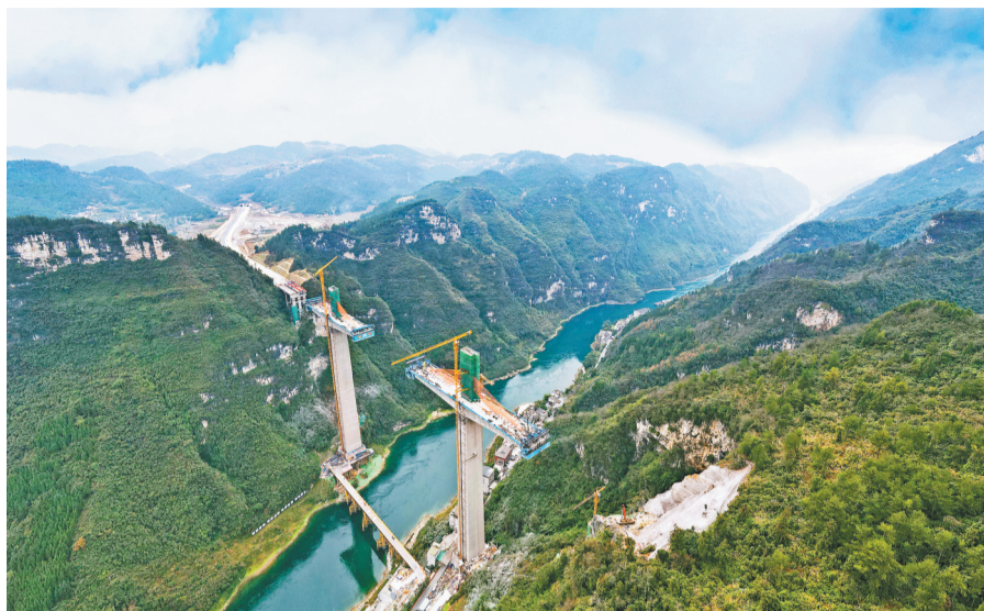
在建的渝湘复线高速磨寨乌江特大桥。(中国铁建港航局供图)
