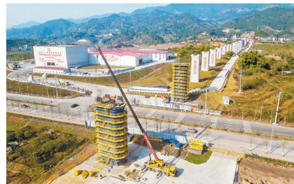
1月4日,西渝高铁开州段起家普里河特大桥,工人们正在桥墩上施工。据悉,该桥为西渝高铁开州段重难点工程,全长1044.2米,预计于2025年3月完工。西渝高铁是国家规划的“八纵八横”高速铁路主通道包(银)海、京昆两大纵向通道的重要组成部分,其中西渝高铁安康至重庆段是第一条横穿大巴山腹地的铁路。
