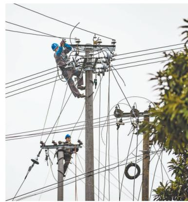
1月5日，开州临江镇永东村，电力工人正在加紧进行10千伏明洪线低电压台区改造工作。元旦节后、春节前夕，我市农村将迎来返乡潮，加上近期寒冷天气影响，居民用电需求大大增加。国网重庆开州供电公司加强输、变、配电设备的检修和改造，确保电网安全度冬及电力平稳有序供应。
