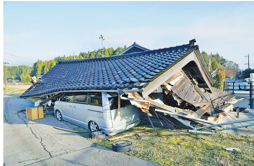
1月2日,在日本石川县鹿町,车辆被压在倒塌的建筑下。 新华社/美联
