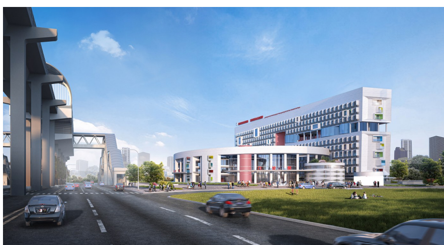
建设中的江津区妇幼保健院新院区(效果图)
