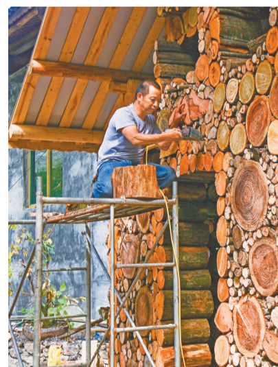
让艺术融入乡村。 百阳花田乡何家岩村，工人正在搭建木艺墙，特约摄影 冉川 视觉重庆
