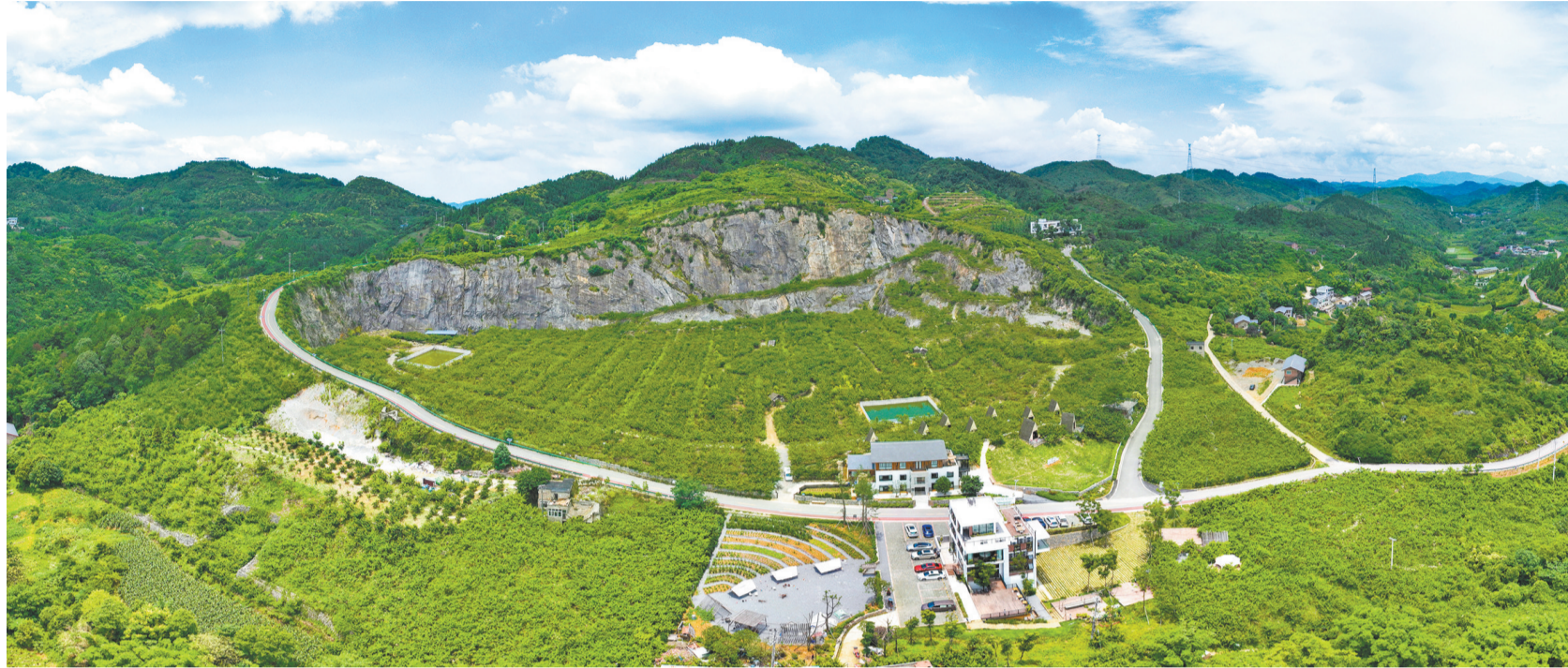
合川区静观镇中华村,对矿山进行生态修复后种上果树,同时整合同置村民宅基地建成民宿和乡村驿站,助力乡村振兴。(受访者供图)
