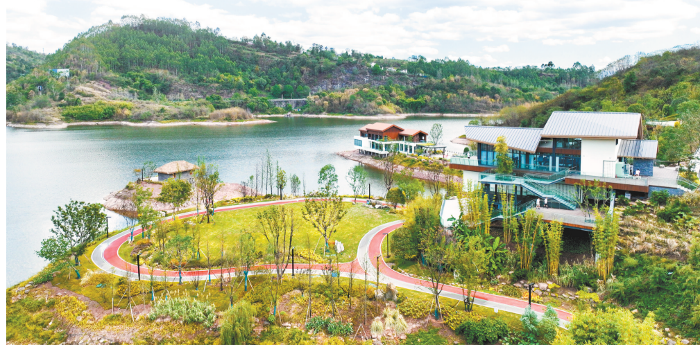
涪陵慧谷湖科创小镇部分楼栋已完成建设。
