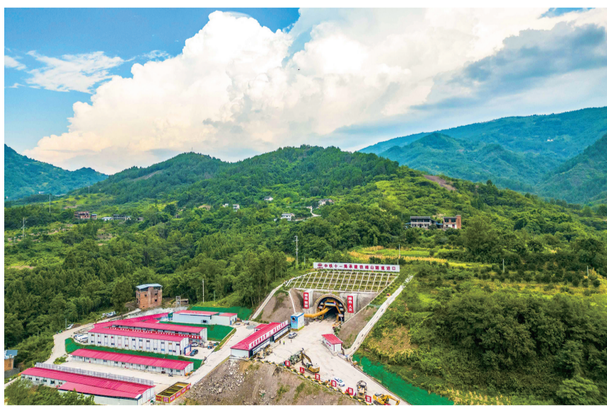
自然资源要素保障助力渝西高铁建设有序推进 摄/尹诗语
