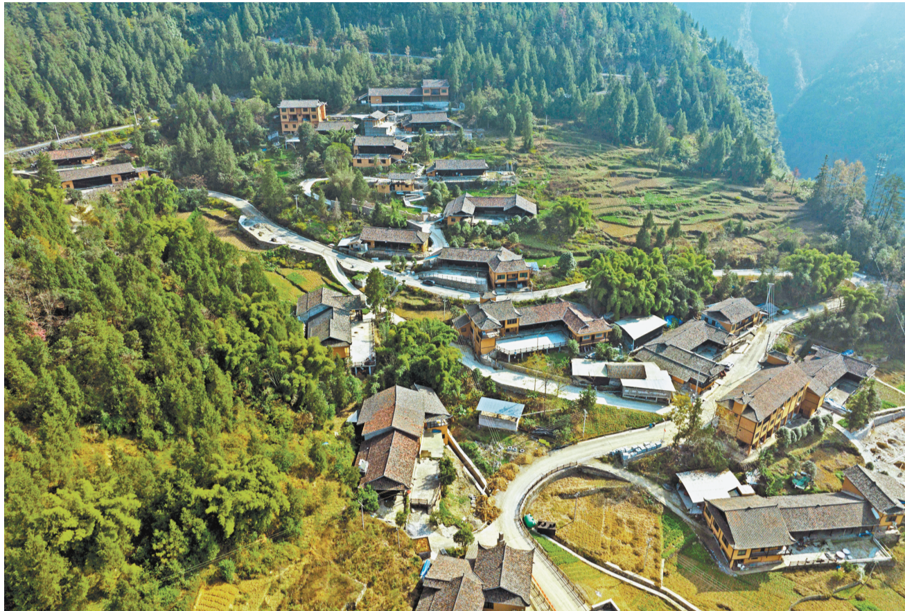
彭水县绍庆街道阿依河社区胡家湾苗寨建筑群,正在修缮改造。
