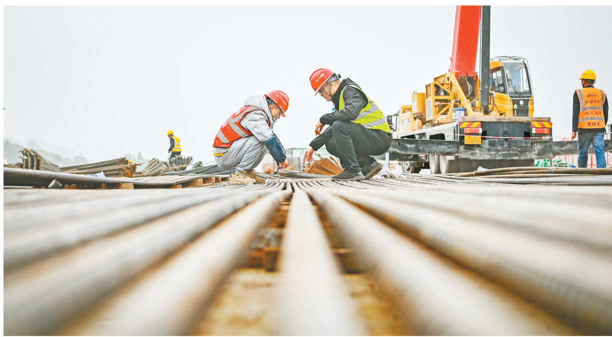
十二月八日,重庆轨道交通二十四号线鹿角车辆段建设现场,项目管理人员正在检查钢筋材料型号、规格等。首席记者 龙帆 摄/视觉重庆
