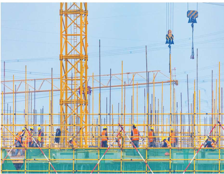
花石中学施工现场 摄/李彦彦
