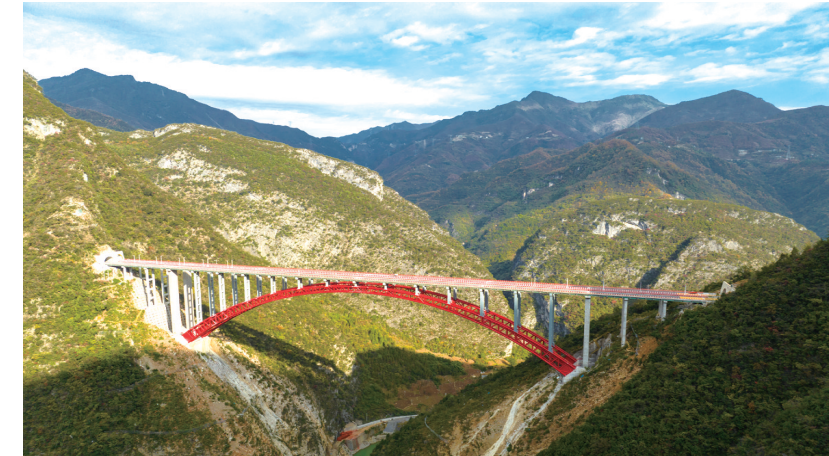
东溪河特大桥
