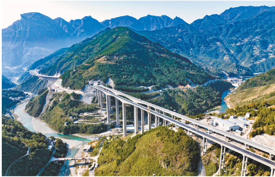
12月4日,巫镇高速建成通车。图为巫镇高速西溪河特大桥。 记者 罗斌 摄/视觉重庆
