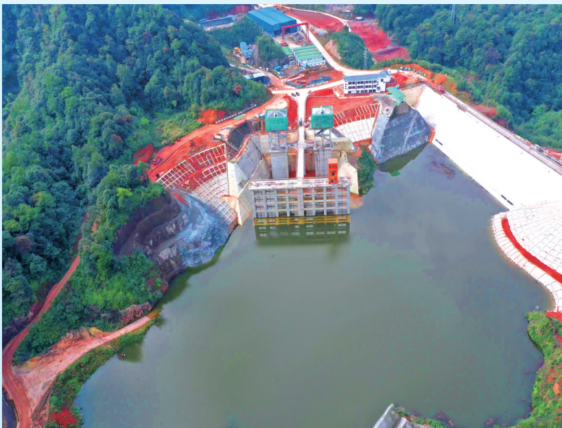
蟠龙抽水蓄能电站(一期)
