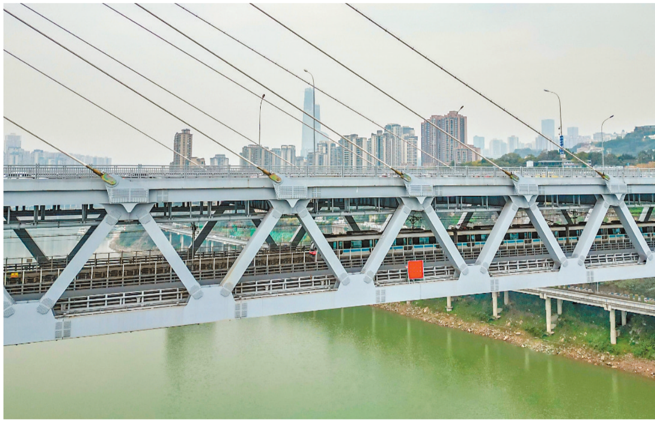
轨道交通5号线调试列车经过红岩村嘉陵江大桥。
